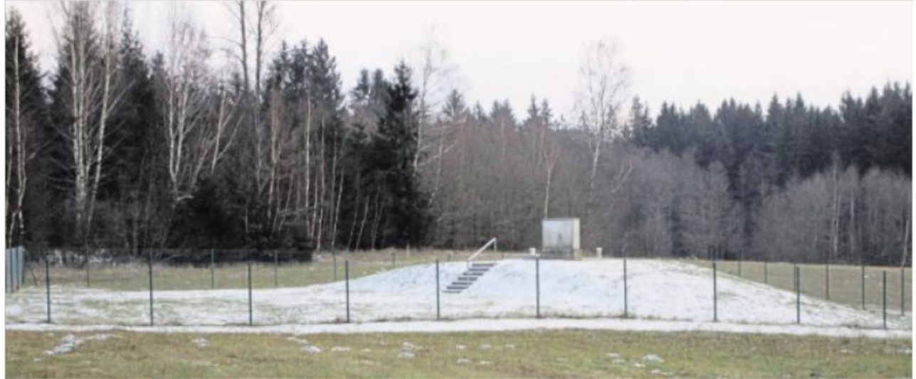
Die Wasserentnahme aus dem Tiefbrunnen beim „Bursweiher“ überschritt die erlaubte Höchstmenge teilweise bis um das Sechzehnfache.
